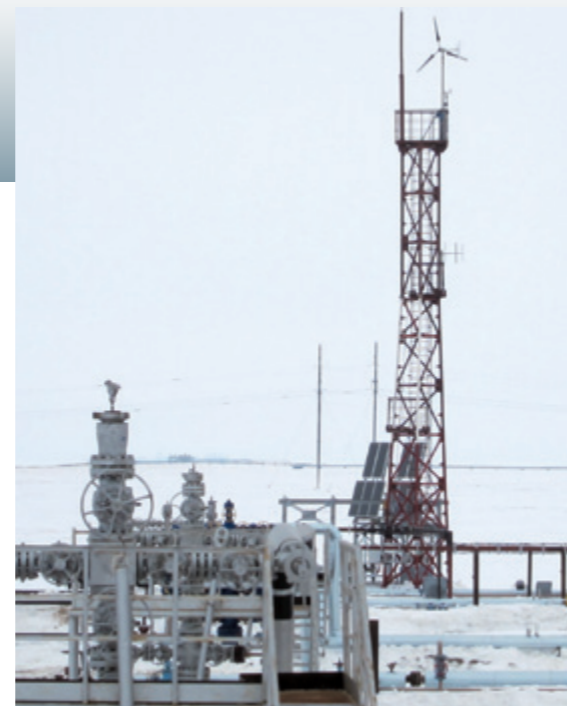
Рис. 1. Куст газовых скважин
